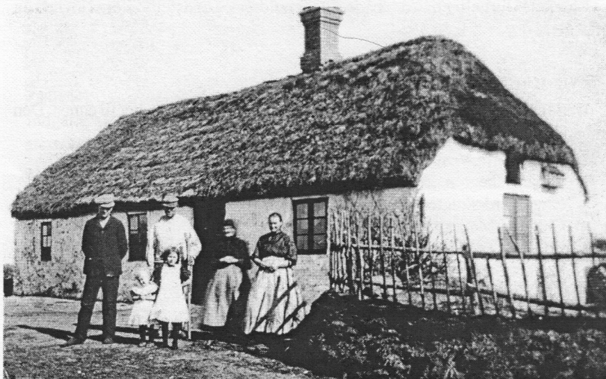
Flintehuset ved Sevel Kalkværk omkring år 1900.
